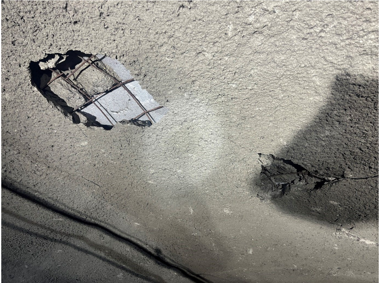
Figur 1: Oppsprukket sprøytebetong ved profil 1925. Ble rensket løs betong.
