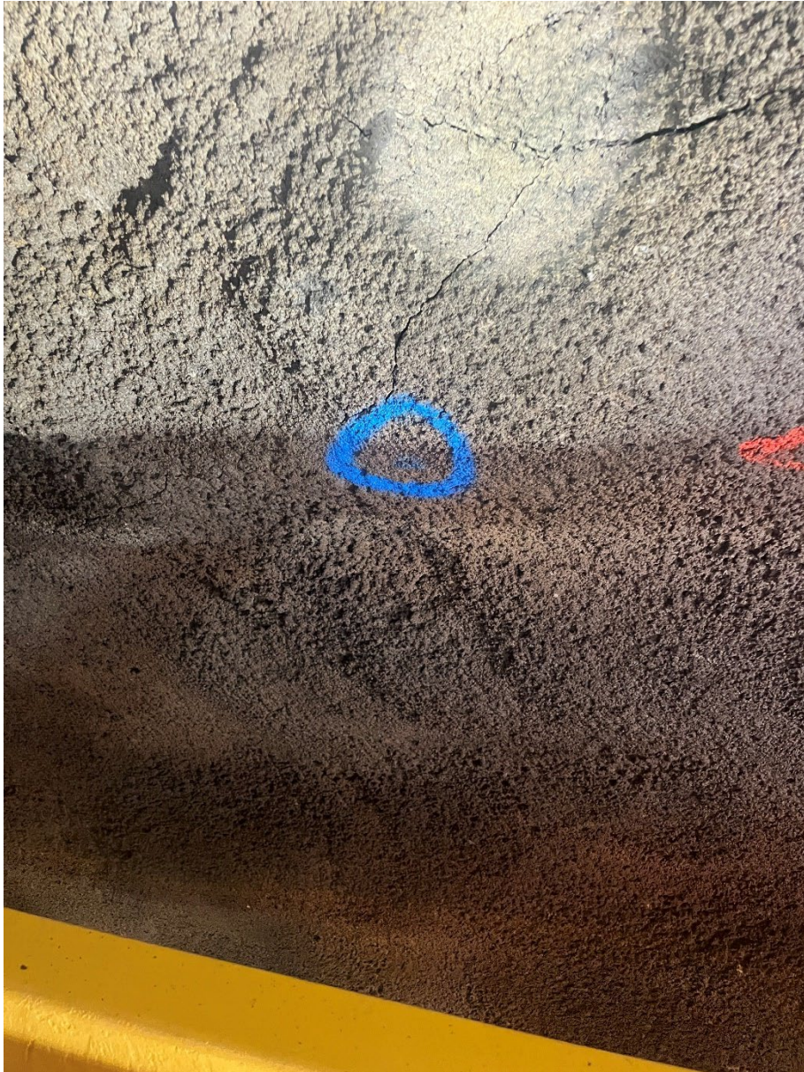
Figur 2: Bom i sprøytebetong ved profil 2340. Anbefalt to stk. bolt.
